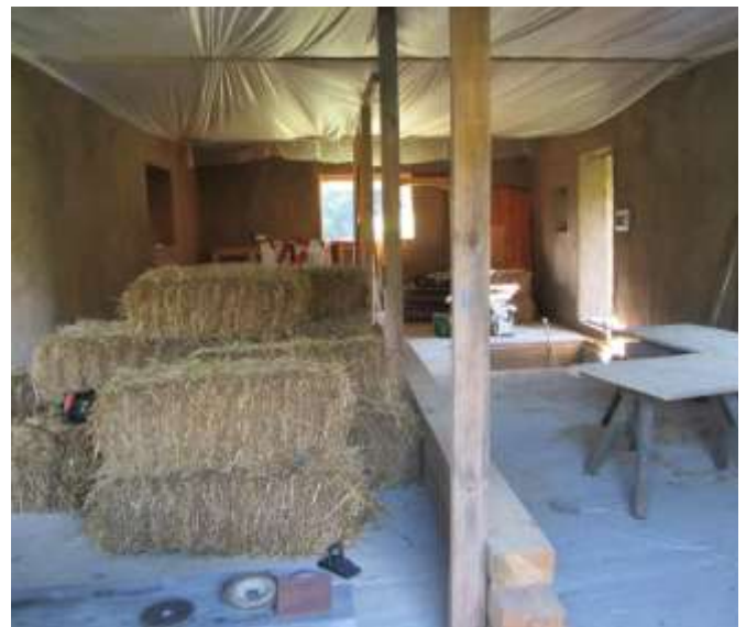
Costruzione di una casa di paglia
