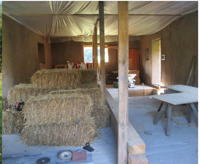
Gradnja slamnate hiše
